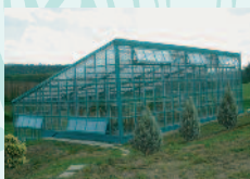
Municipalité de NOTINCS (Hongrie) 2004 Capacité de traitement de 420 m 3 /jour
