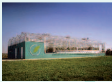
HARBOR PARK KFT NAGYTETENY (Hongrie) 2001 Capacité de traitement de 300 m 3 /jour
