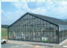
Municipalité de ÖKOPARK HARTBERG (Autriche) 2004 Capacité de traitement de 40 m 3 /jour
