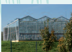
Municipalité d'ETYEK (Hongrie) 2007 Capacité de traitement de 1 000 m 3 /jour
