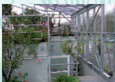
Municipalité de KISDOROG (Hongrie) 2004 Capacité de traitement de 100 m 3 /jour
